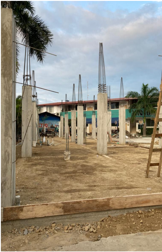
Figura 7. Cimentación del terreno y preparación de primera loza.
