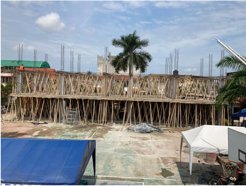
Figura 9. Encofrado de segunda loza.
