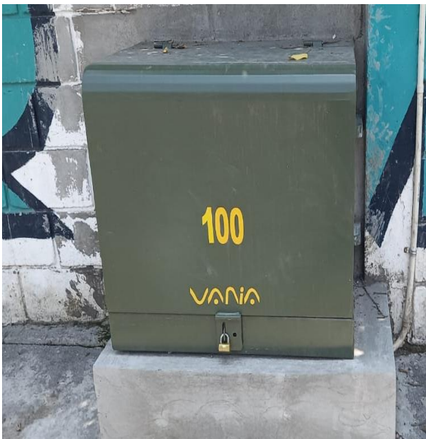
Figura 13. Instalación de Transformador 100 KWA.
