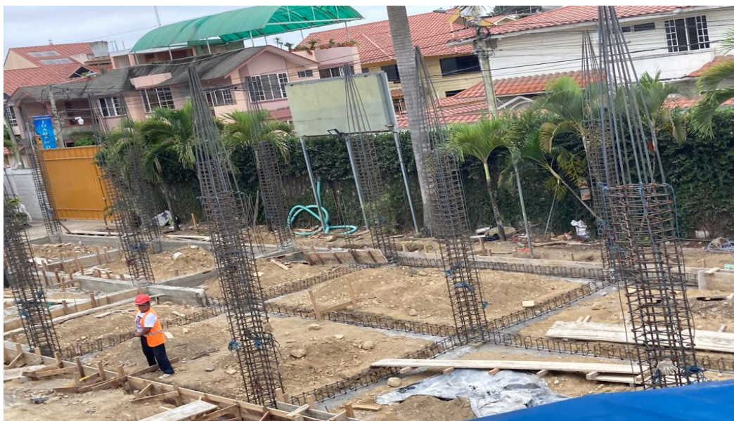
Figura 6. Plintos y levantamientos de columnas
