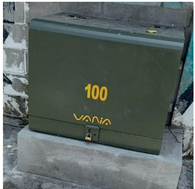
Figura 13. Instalación de Transformador 100 KWA.
