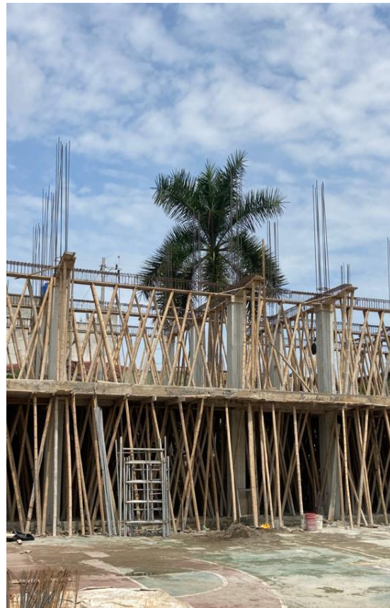
Figura 8. Fundición de primera loza y levantamiento de columnas.
