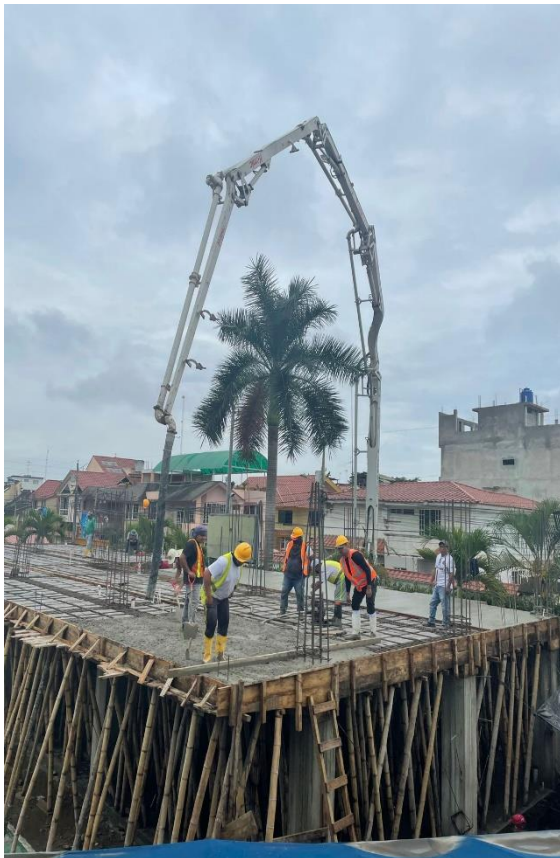
Figura 8. Fundición de primera loza y levantamiento de columnas.
