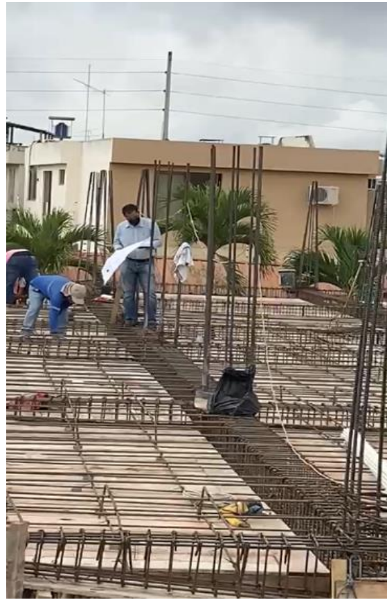
Figura 7. Cimentación del terreno y preparación de primera loza.
